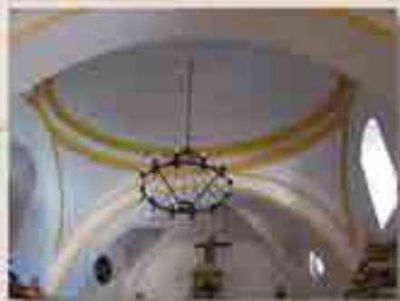
BÓVEDA CRUCERO Y PREBISTERIO
