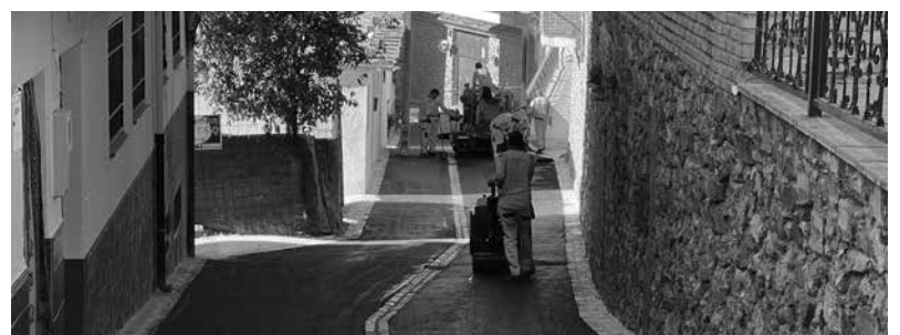
La calle ya está abierta tanto de forma peatonal como al tráfico rodado.
