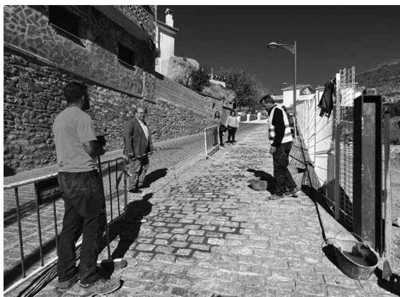
El primer edil supervisa los últimos retoques a la vía.
