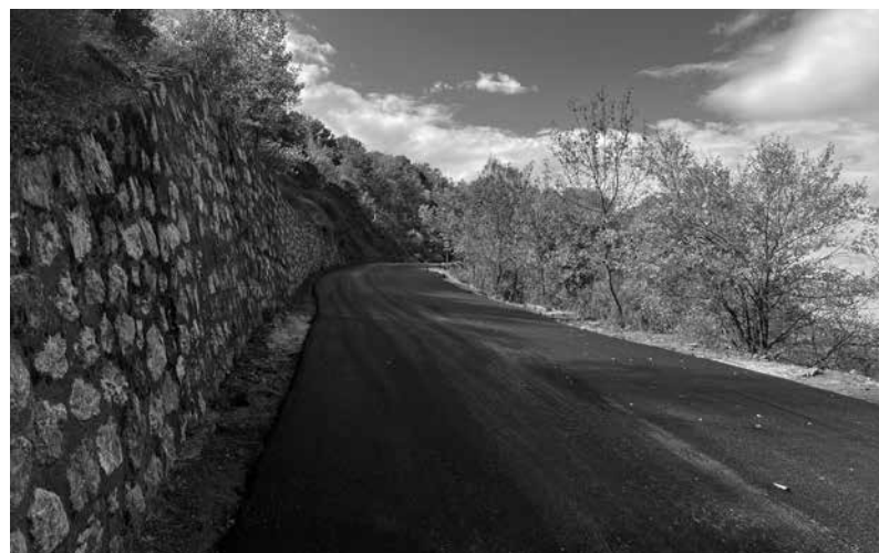
Uno de los puntos de Hazas Llanas donde se ha actuado.
