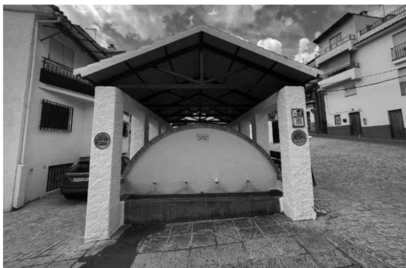
Aspecto del lavadero de Eras Bajas tras su acondicionamiento.
