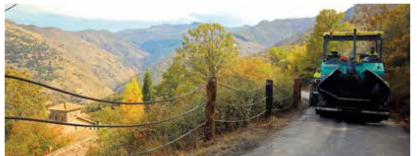
Una máquina trabajando en la zona
