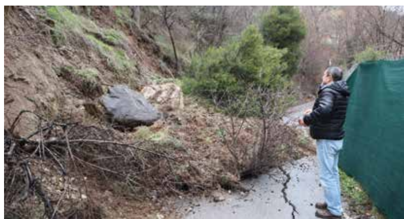
Daños registrados en Las Solanillas
